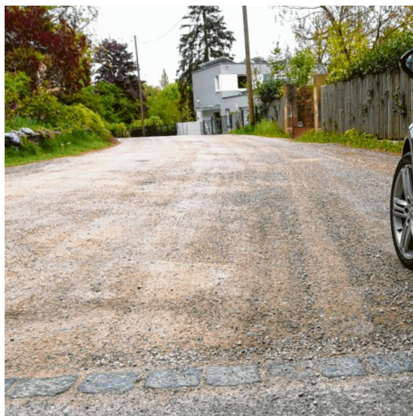
Wenn am Himmelreich in Westheim künftig weitergebaut werden sollte, stellt sich der Planungsausschuss die Frage, ob irgendwann die komplette Fahrbahn der Straße asphaltiert werden müsste. Bisher mündet sie in eine Schotterpiste. Foto: Marcus Merk
