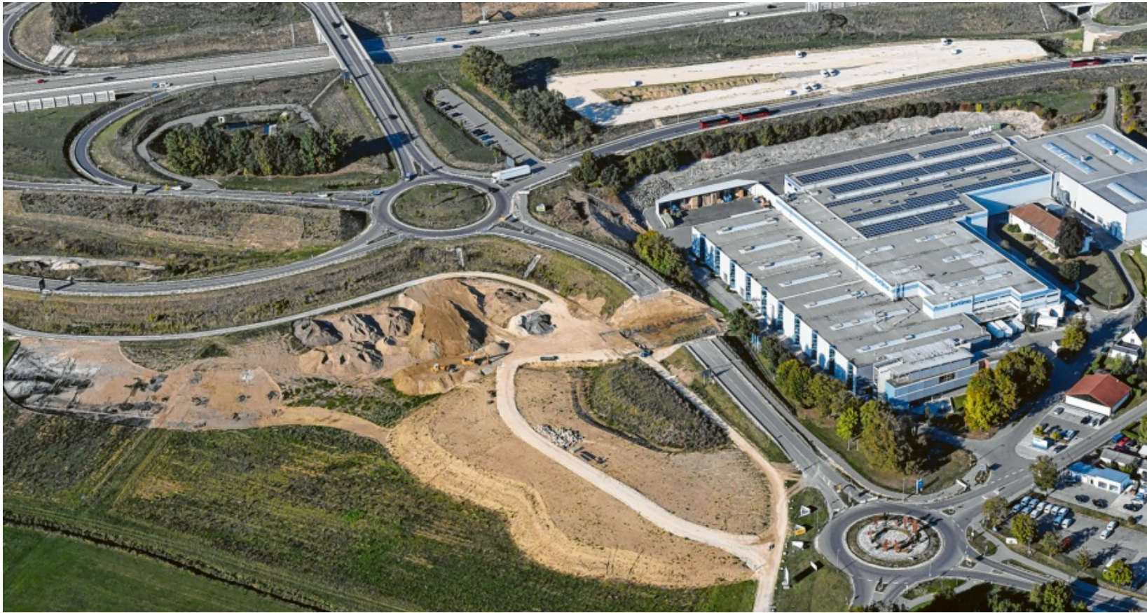
Hier, an der A8 bei Zusmarshausen, soll die größte Solartankstelle der Welt entstehen.
