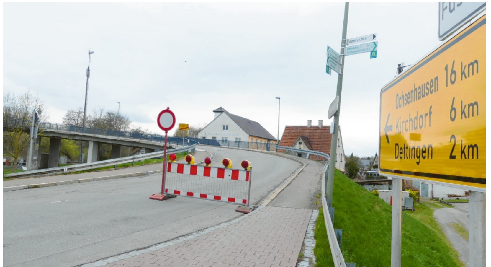
Hier geht es nicht weiter: Die Brücke, die Kellmünz mit Kleinkellmünz verbindet, muss saniert werden. Die Sperrung gilt seit dem 1. April. Für die Autofahrer bedeutet das eine große Einschränkung. Foto: Zita Schmid
