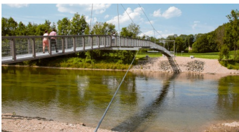
Bei Legau im Landkreis Unterallgäu können Besucher auf einer Hängebrücke die Iller überqueren. Archivfoto: Christina Bleier, LEW
