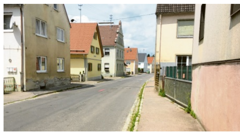
Die Engstelle bei der Hausnummer 61 war ein Diskussionspunkt bei der Gemeinderatsitzung in Burtenbach zur Sanierung der Ortsdurchfahrt. Foto: Zimmermann
