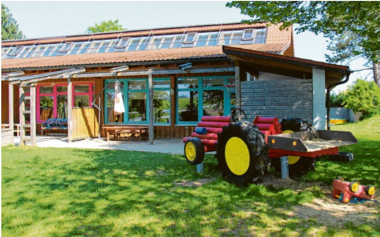
Im Osten des jetzigen Kindergartens (auf dem Bild rechts) soll der größere der beiden geplanten Anbauten entstehen und Platz für eine dritte Kindergartengruppe bieten.
