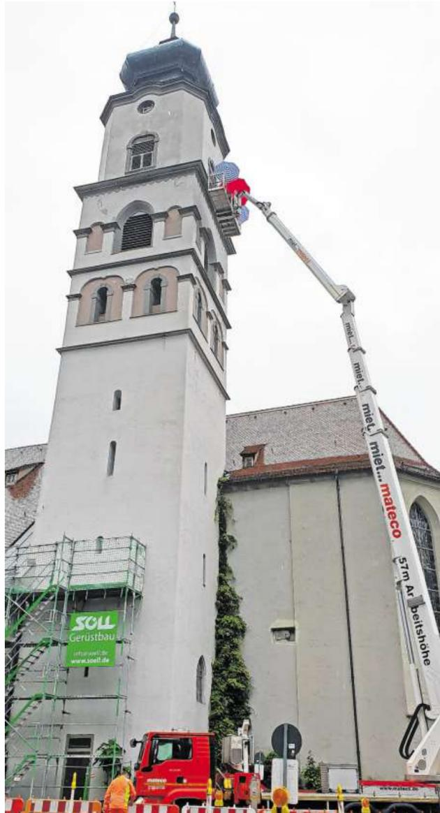
Auf einer Hebebühne, die bis auf 57 Meter Höhe ausgefahren werden kann, untersuchen Mitarbeiter eines Gutachterbüros – von Schirmen gegen Regen geschützt – das Mauerwerk des Turms der Stephanskirche auf der Insel. Foto: Ulrich Stock
