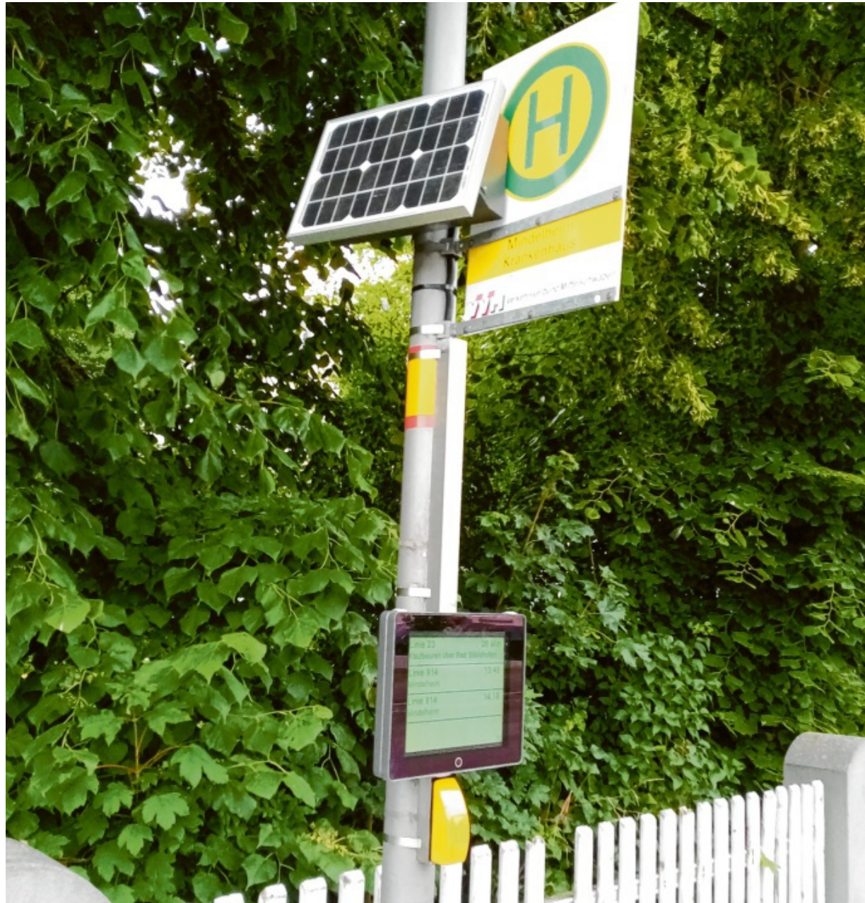
An dieser Bushaltestelle beim Mindelheimer Krankenhaus wurde eine Anlage für dynamische Fahrgastinformation getestet. Displays in dieser Größe sollen künftig an Haltestellen in Weißenhorn und den Ortsteilen zum Einsatz kommen. Foto: VVM
