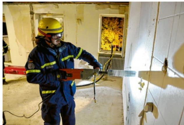
Das Kernbohrgerät ermöglicht einen Blick in verschlossene Räume ohne den Bedarf an großen Öffnungen. Fotos: Jannis Rauh
