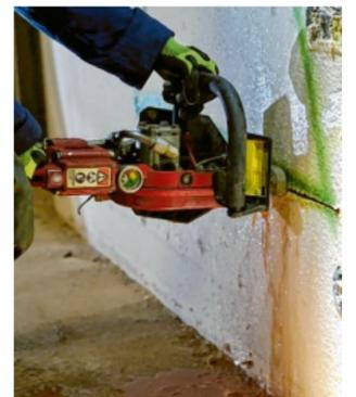
Mit der hydraulischen Spezialsäge schneidet man Stahlbeton sowie Stein.
