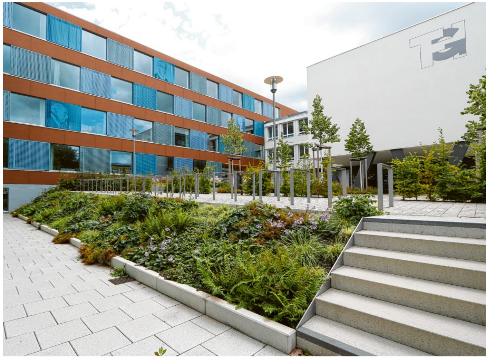
In den nächsten Wochen findet der Abschluss der Generalsanierung des Nördlinger Theodor-Heuss-Gymnasiums statt.
