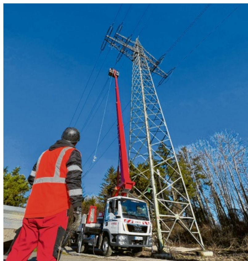
Die LEW-Verteilnetz erneuert derzeit die Leiterseile und Isolatoren der 110-Kilovolt-Hochspannungsleitung. Foto: Bernd Feil
