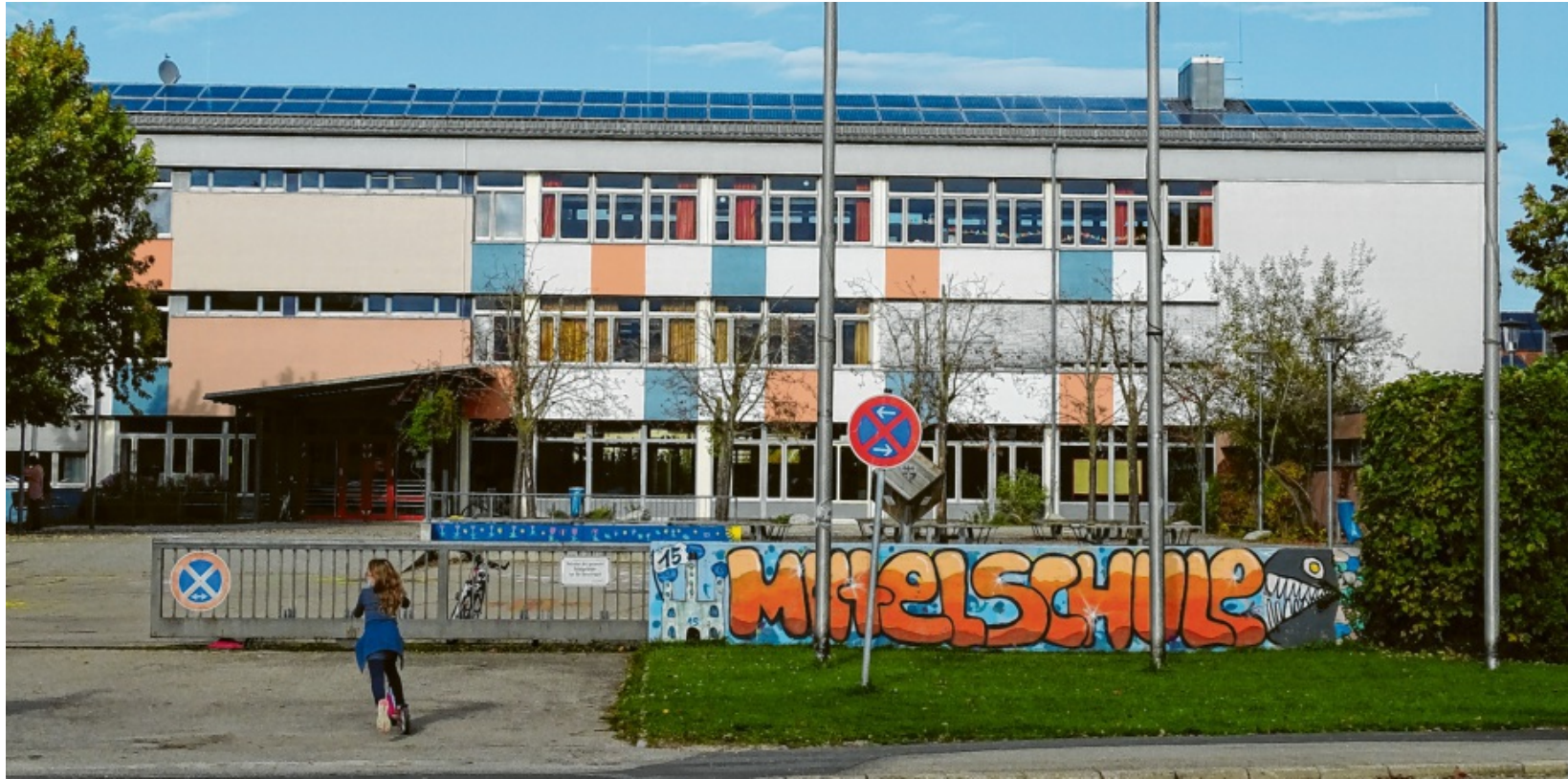
Auf dem Schuldach in Merching entstand vor 20 Jahren die erste Bürgersolaranlage des Landkreises. Jetzt sollen die Kollektoren als Geschenk an die Gemeinde übergeben. Foto: Brigitte Glas
