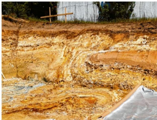
An den Wänden der Baugrube sind verschiedene Bodenschichten zu erkennen. Foto: Werner Paa
