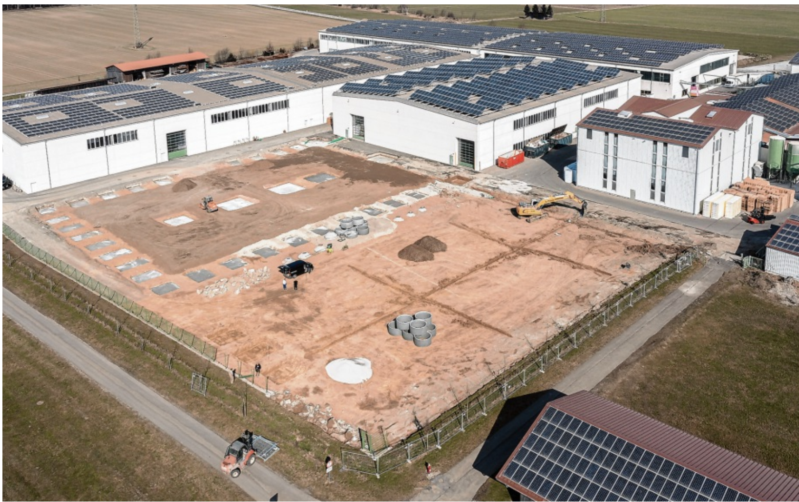
Auf diesem Gelände erweitern die Joma Dämmstoffwerke ihre Lager und Produktionsflächen in Holzgünz für 3,3 Millionen Euro.
