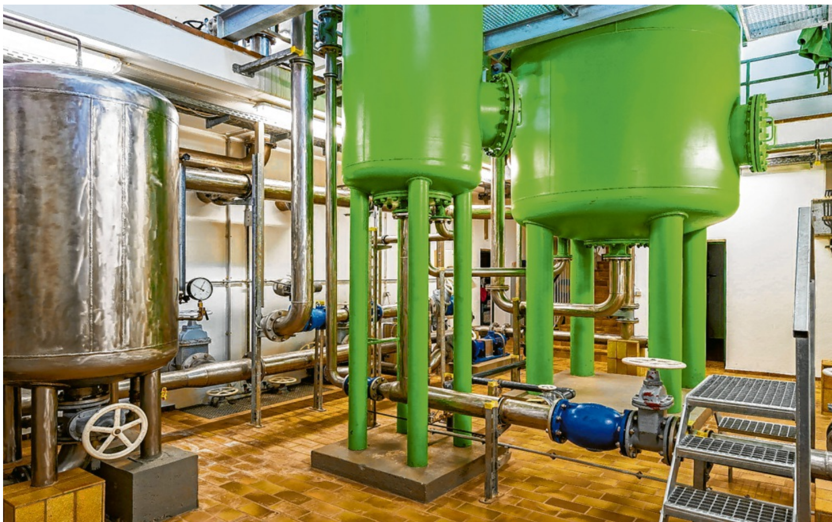
So sieht es im Wasserwerk Pfaffenhofen, das neu gebaut werden muss, von innen aus. Foto: Eckhart Matthaeus
